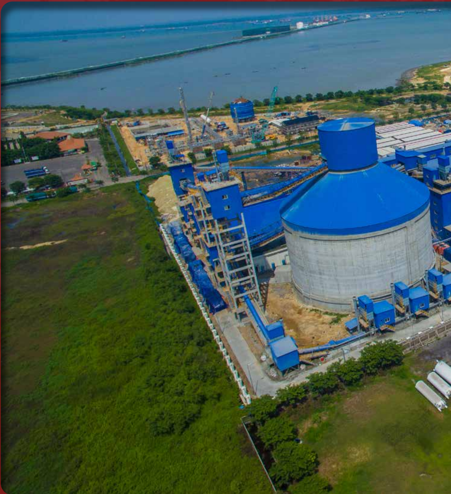
Pabrik Penggilingan Semen Gresik, Indonesia / Gresik Cement Grinding Plant, Indonesia
