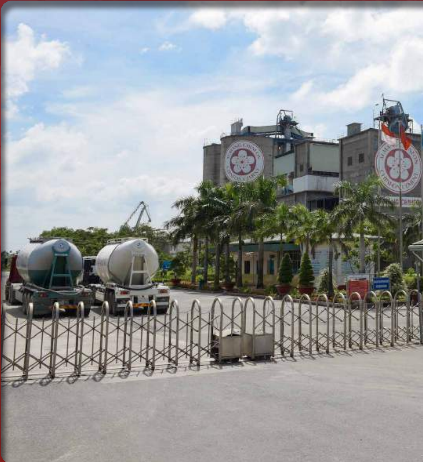
Pabrik Penggilingan Semen Hiep Phuoc, Vietnam / Grinding Plant Cement Hiep Phuoc, Vietnam
