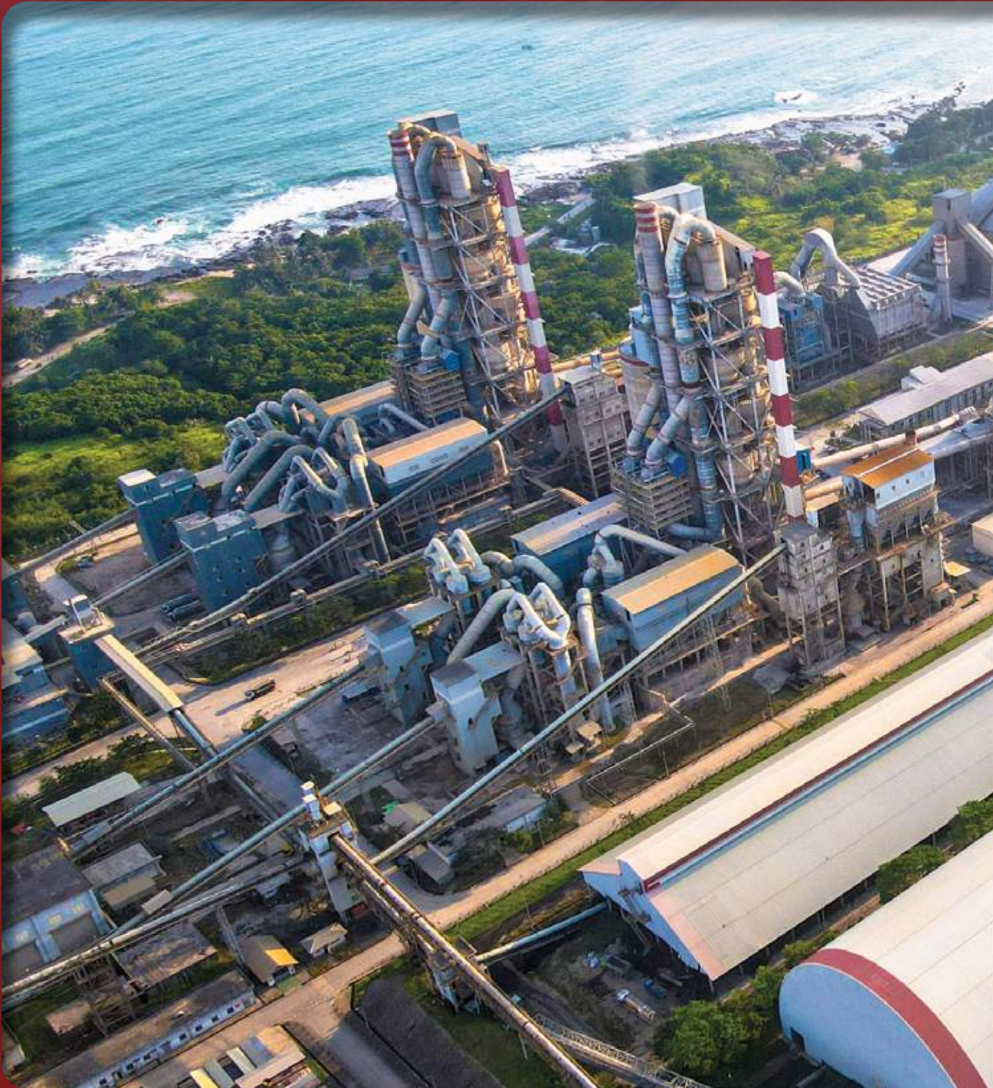
Pabrik Semen Terintegrasi Bayah, Indonesia / Bayah Integrated Cement Plant, Indonesia
