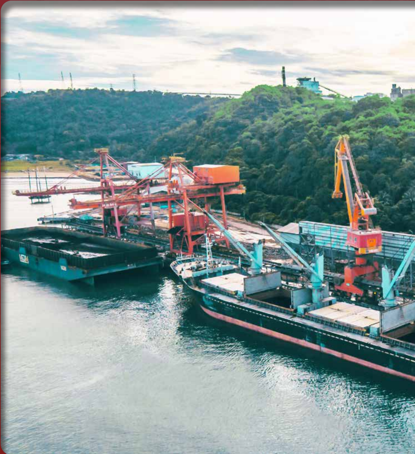
Pelabuhan di Pabrik Semen Terintegrasi Bayah, Indonesia / Port at Integrated Cement Plant, Bayah, Indonesia
